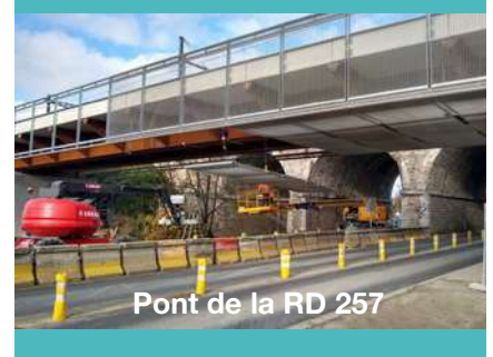
Travaux de la plateforme
