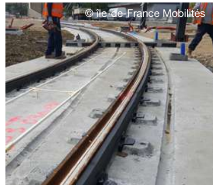
Pose des bordures de quai (nez de quai)
