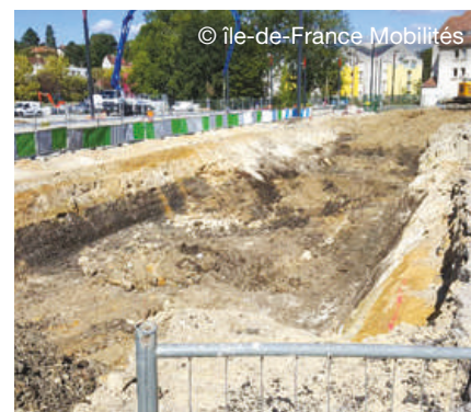
Deuxième bassin de rétention d'eau
