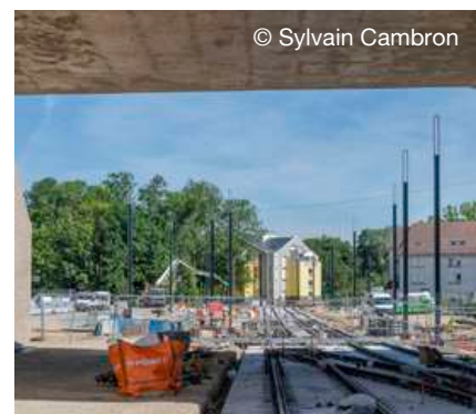
Pose des voies ferrées du pôle multimodal
