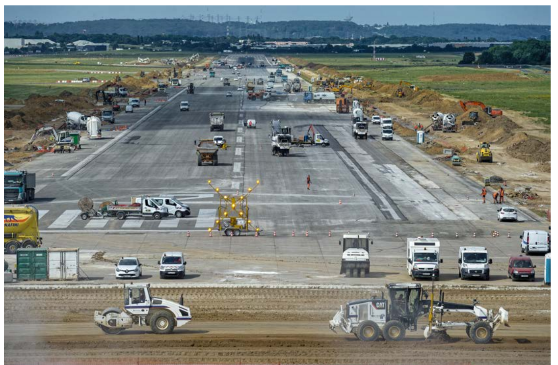
TRAVAUX DE LA PISTE 4 DE PARIS-ORLY, 2016
